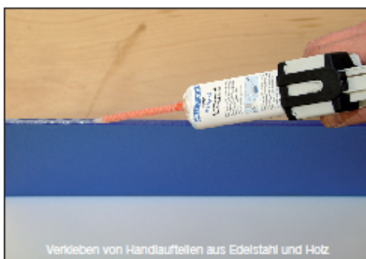
Verkleben von Handlaufteilen aus Edelstahl und Holz
